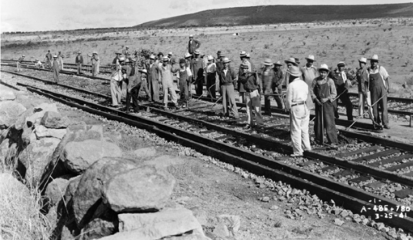
Trabajos de mantenimiento de la vía y cambio de riel en el kilómetro A-485, cerca de la estación Mira, en Jalisco, México, 25 de marzo de 1941. Fondo FNM, sección Comisión de Avalúo e Inventario. Secretaría de Cultura, CNPPCF, Cedif.
